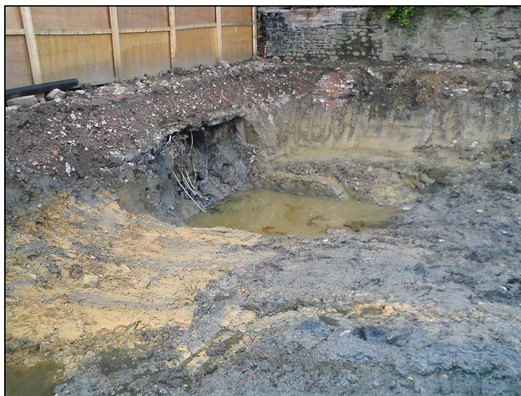
Imagen 13: Contaminación del suelo por depósitos subterráneos de almacenamiento de alquitrán. Fuente: Wikimedia Commons . Autor: Dumelow Licencia: Creative Commons.
